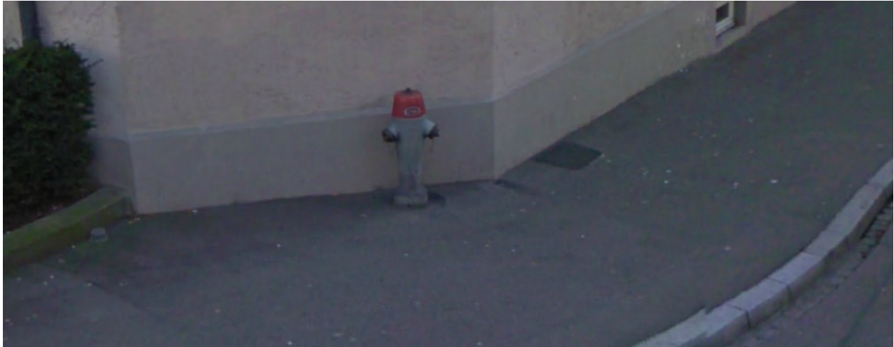
Hydrant. Ecke Zürichbergstraße/Freiestraße, 8032 Zürich
